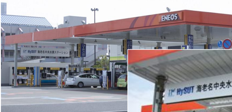
ガソリン計量機・水素充填機併設ステーション（神奈川県海老名市）
